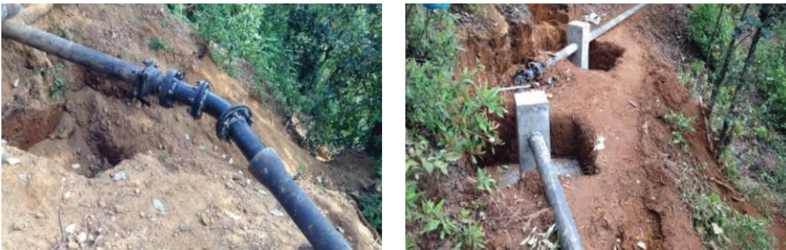
Figura 8. Tubería metálica y de PVC.
